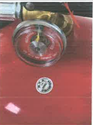
三樓滅火器雷射標籤
